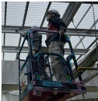
高所作業車での作業
