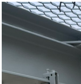
施工後（塗装完了した状態）
